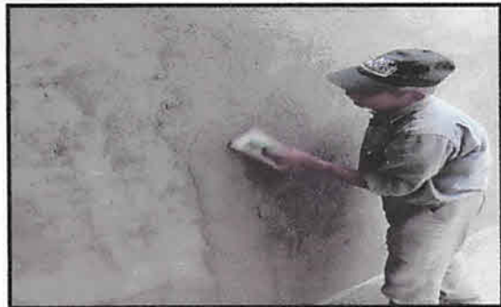
Foto 10 : Reemplazo de repello y cernido.
