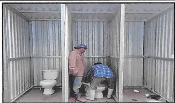
Foto 5: Reemplazo de sanitarios
