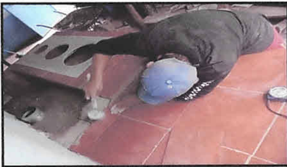
Foto 9: Reconstrucción de estufa con plancha y chimenea
