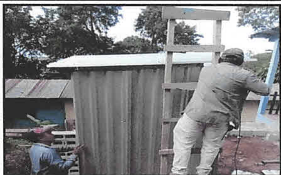
Foto 3: Reemplazo de techo y estructura metálica a los sanitarios.
