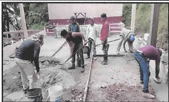
Foto1: Reemplazo de piso de salon y comedor
