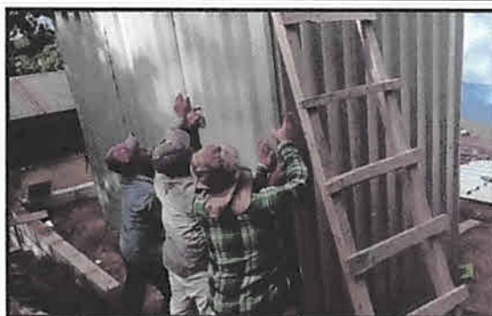
Foto 2: Mejoramientos de sanitarios con paredes de lámina troquelada y costaneras.
