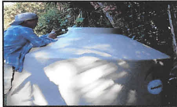
Foto 8: Reemplazo de tinaco.
