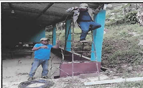
Foto 6: Reemplazo de cableado de electricidad
